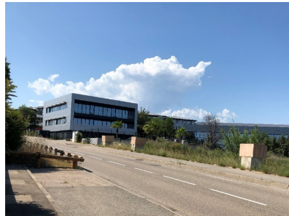
FIGURE 8 : PLOTS DE REPERAGE DE LA NAVETTE
