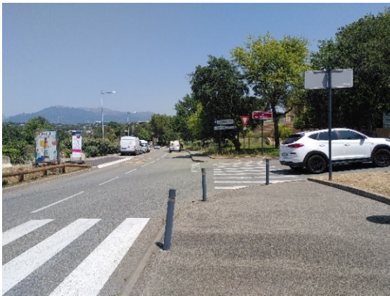
FIGURE 7 : INTERSECTION SUR L'AVENUE DE ROUMANILLE
